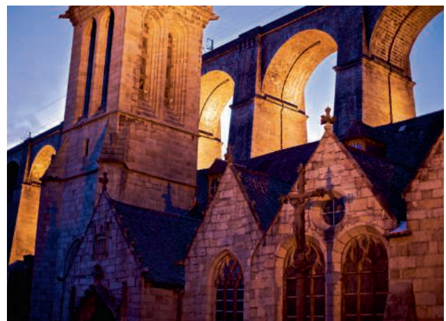
LE VIADUC DE MORLAIX.
